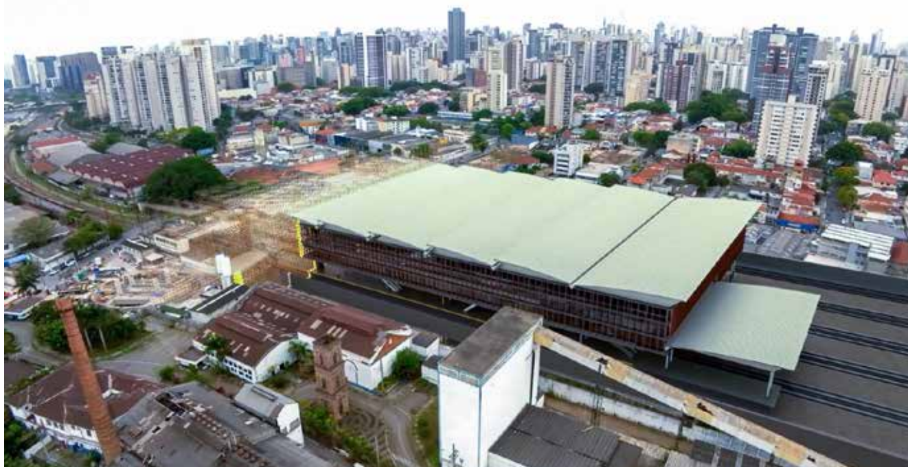
A TIC Trens será responsável pelas obras de modernização e ampliação da estação Água Branca
