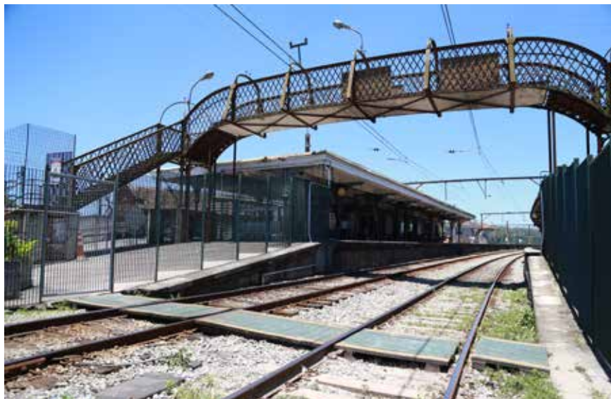
Estação Rio Grande da Serra
