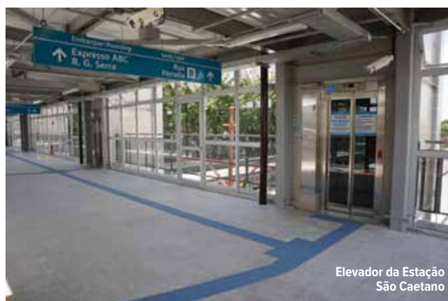
Passarela metálica da Estação São Caetano
