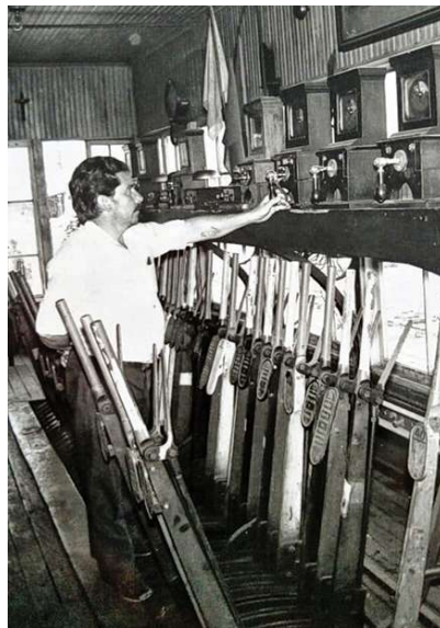
Operador no controle de tráfego ferroviário.
