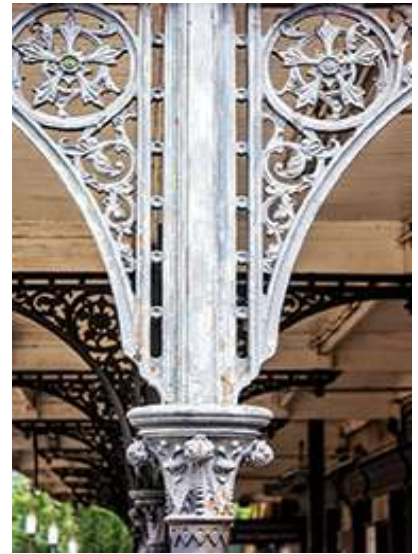
Nova estação Brás com colunas em estilo vitoriano.
