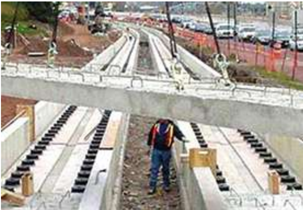
Tipo de solução: Apoios discretos Frequência: 5Hz a 12Hz (Getzner)
