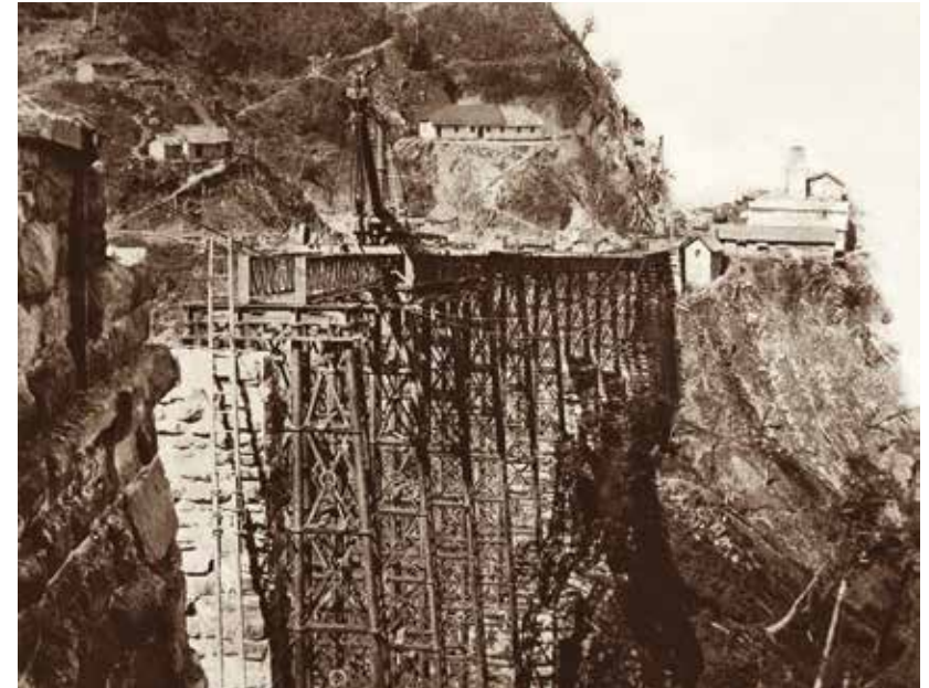
Imagem 6 – Construção do viaduto da Grotta Funda na Serra do Mar, 1864 - Militão Augusto de Azevedo/ Coleção Gilberto Ferrez/ Acervo Instituto Moreira Salles.
