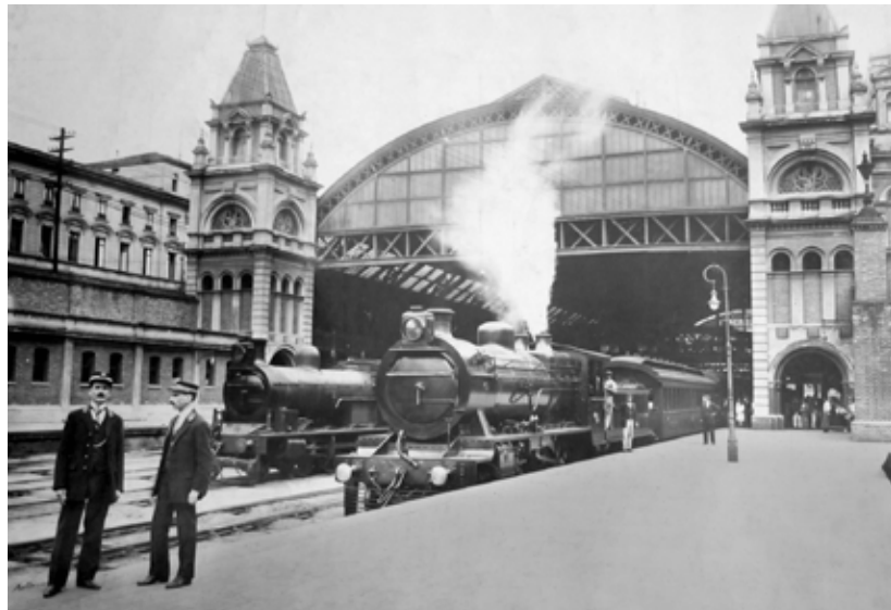
Imagem 33 – Vista da Estação da Luz para o lado de Santos – Acervo Arquivo Público do Estado de São Paulo.
